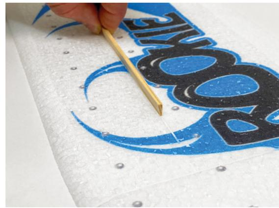
Ein Kiefernholm gibt dem Rookie-Flügel seine Stabilität, der dreieckige Querschnitt des Holms sorgt für das Knickprofil der Fläche.
